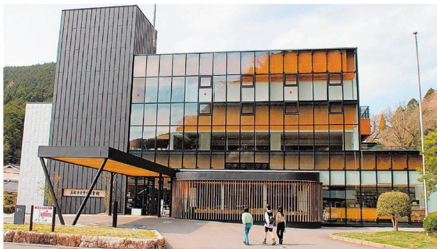
内外装にCLTを取り入れた中央図書館
